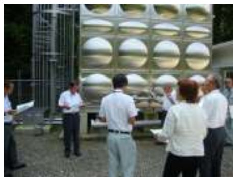
上三財浄水場の現地調査
