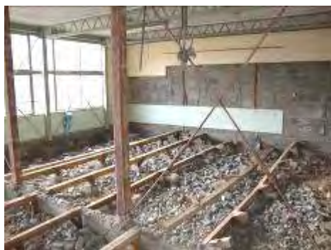
旧一ツ瀬小学校の改修工事の様子
