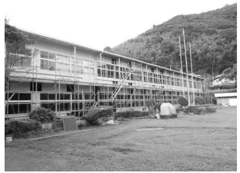
耐震補強工事中の銀鏡中学校舎
