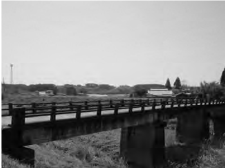
補修される三納地区永代橋
