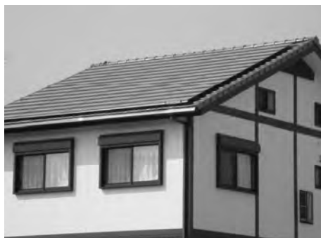
一般住宅に設置してある太陽光発電
