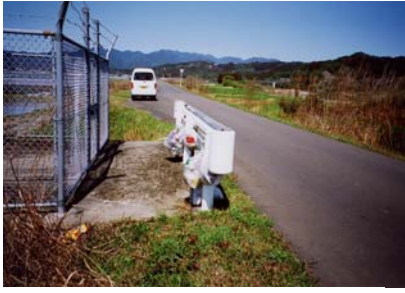
ごみの不法投棄（一ツ瀬川堤防）
