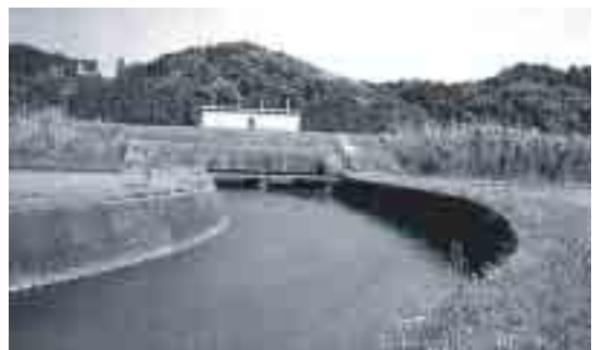
▲早急な排水ポンプの設置が求められる桜川ひ門
