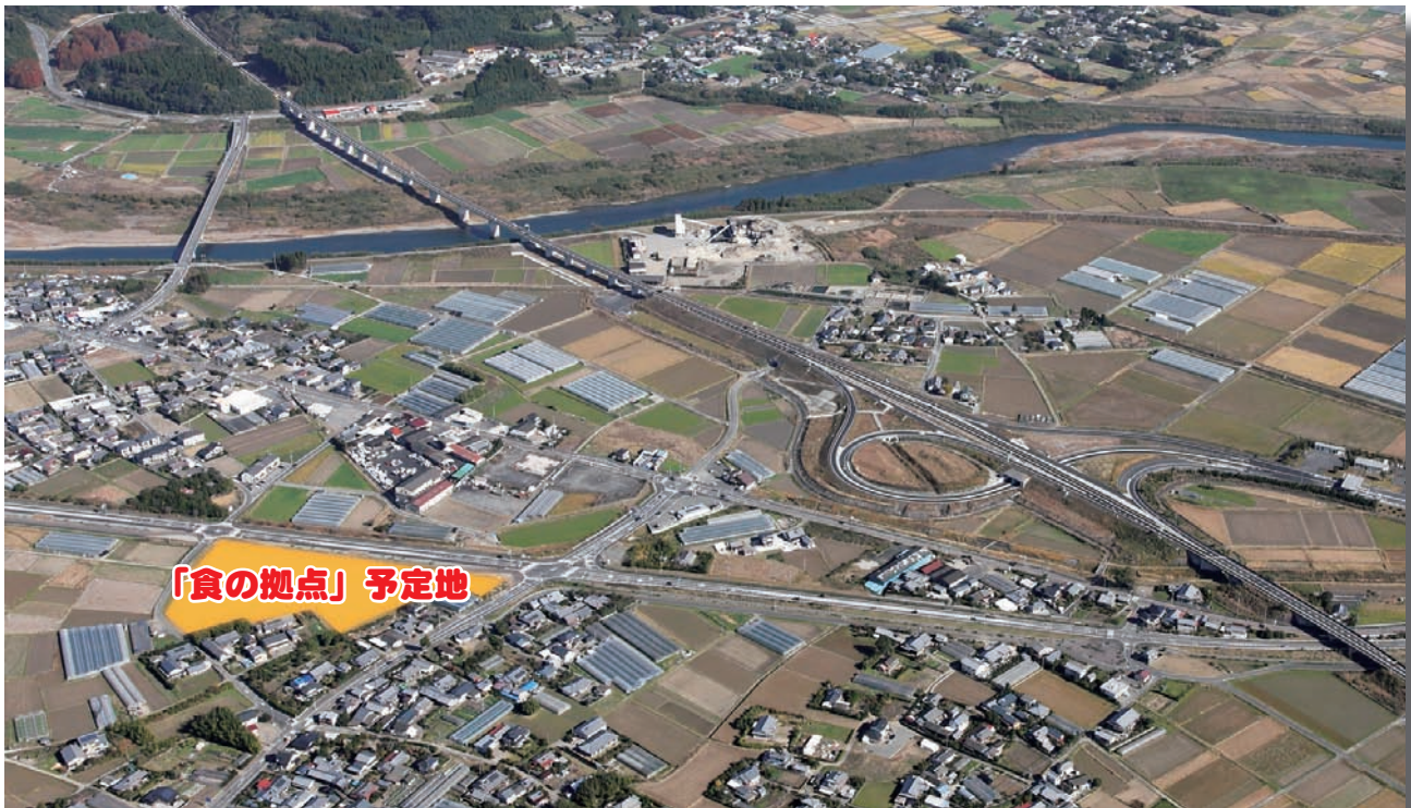
四日市周辺の様子（航空写真）。建設場所は西都インターチェンジの近くであり、東九州自動車道が開通すれば、まさに本市の玄関口となる
