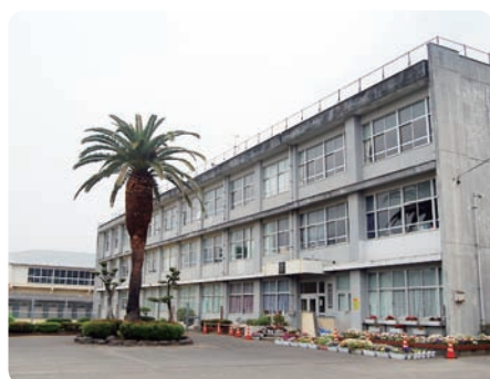
耐震補強工事が行われる『穂北中学校』
