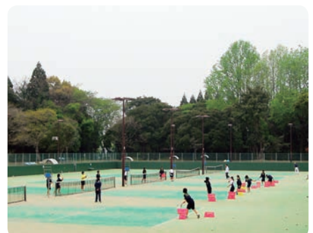
照明設備が設置される 西都原運動公園『テニスコート』
