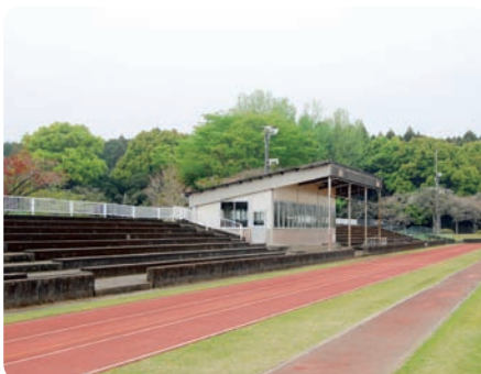
観客席の屋根などが設置される 西都原運動公園『陸上競技場』
