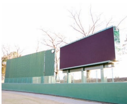
新たに設置された電光掲示板
