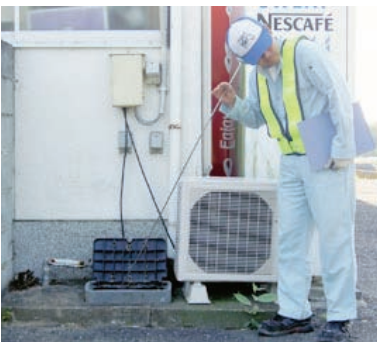
メーター周辺での漏水調査
