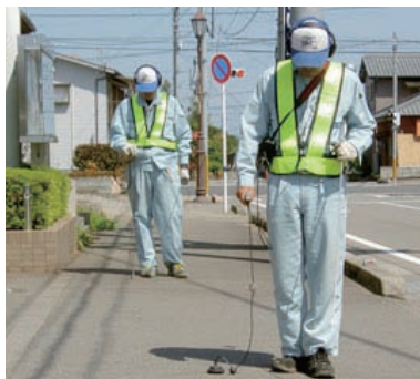
道路上での漏水調査
