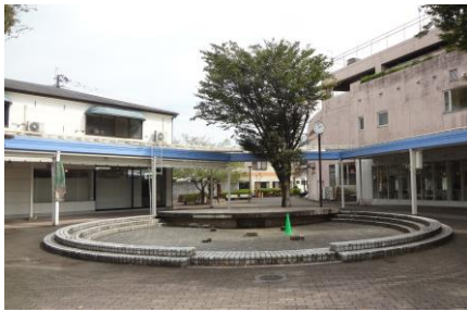
噴水施設改築予定の あいそめ広場
