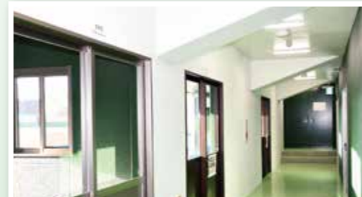
▲一塁側ダッグアウトに向かう通路 新たに医務室、アップ室が設置されました。
