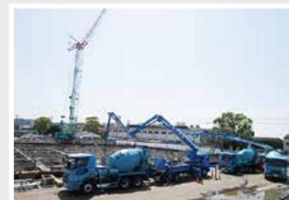
▲多数のミキサー車で生コンクリートを運搬します。
