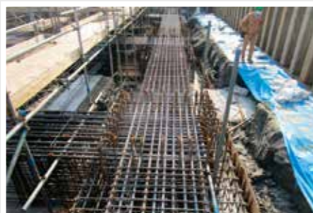
▲基礎の鉄筋を組み立てている途中です。構造体の中には多くの鉄筋が入っています。
