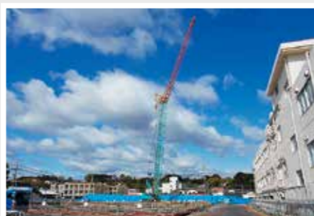
▲市内ではなかなか見ることのない大きな重機も活躍しています。
