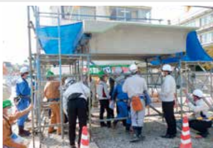
▲天井の模型を製作し、器具類の設置方法を検討しています。
