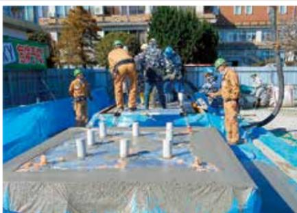
▲基礎コンクリート模型の製作風景。模型を製作することで、実際に工事をする時の段取りなどを確認します。
