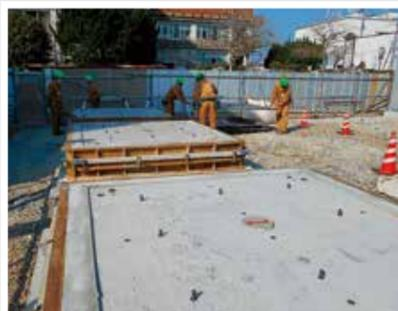
▲模型が完成しました。実際の工事ではこの上に免震装置が設置されます。
