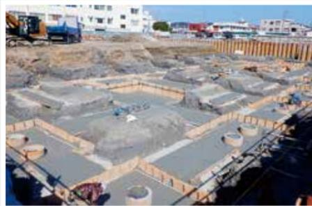
▲土砂を掘削し、杭の先端が見えてきました。この後、建物の基礎を造っていきます。
