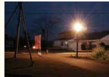
▲記紀の道の沿線に照明設置 (石貫階段下まで完了)
