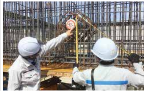
▲空調和設備の配管を設置するため、梁を補強し配管位置を確認しています。
