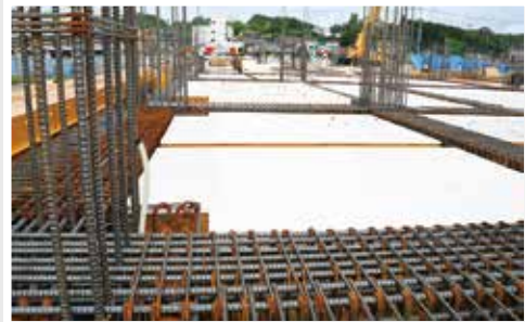
▲待合ホールがある1階床を工事中です。多数の鉄筋を組み合わせた大梁で床を支えます。1階床下に断熱材を敷き込み、コンクリートの表面結露を防ぐ対策をしています。
