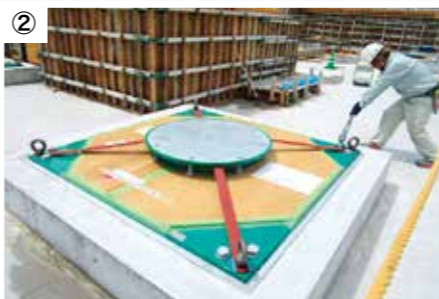
▲「弾性すべり支承」と呼ばれる装置です。建物を滑らせて、地面の揺れをほとんど伝えないようにします。
