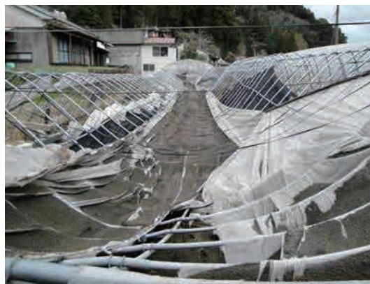
新燃岳の噴火に伴う降灰の重みによる ハウス被害
