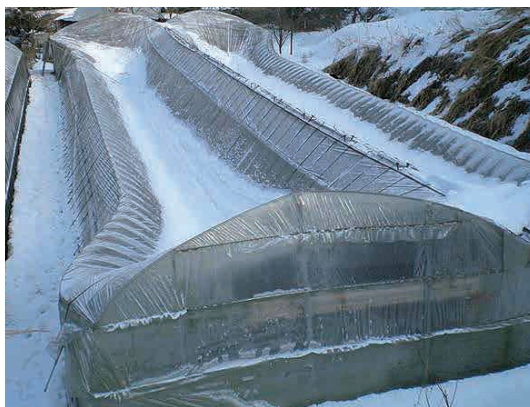
雪の重みによるハウス被害
