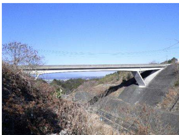
図 9 高速道路を跨ぐ橋梁の例（西都市管理 別府原橋）
