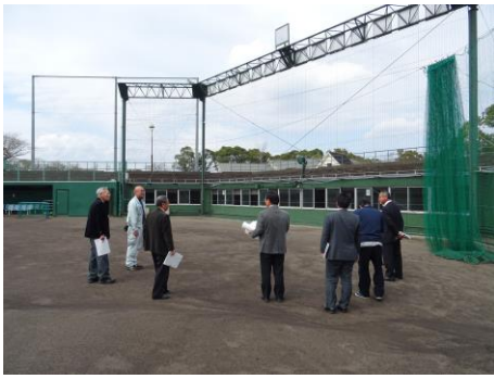
西都原運動公園野球場改修工事 現地調査
