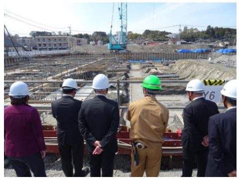
新庁舎建設工事 現地調査
