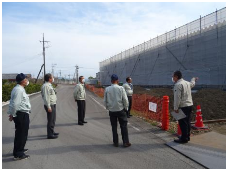
協栄木材（株）西都工場（三財） 現地調査
