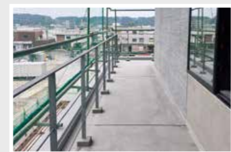
▲新庁舎棟 バルコニーにメンテナンス用の手すりが設置されました。東西南北の4面に設置予定です。
