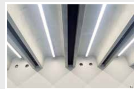
▲新庁舎棟 執務室に照明器具が設置されました。照度を計算し、等間隔に配置しています。
