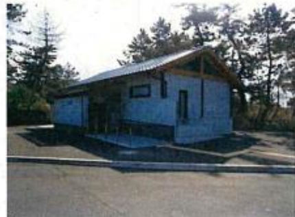
浜の宮公衆トイレ新築事業（H24～H25）
