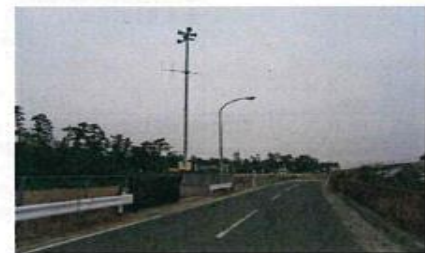
防災行政無線屋外拡張支局（H24）
