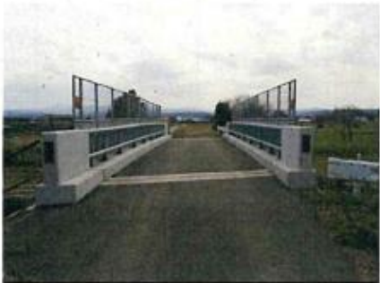
新田跨線橋改修事業（H25）
