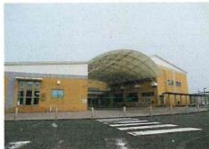
築上町コミュニティセンター・ソピア建設事業（H22-H24）
