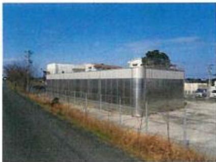
高塚浄水場改良事業（H20～H22）
