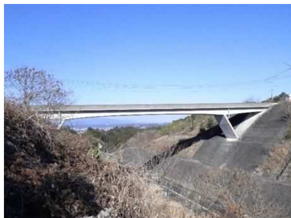
図 10 道路を跨ぐ橋梁の例（西都市管理 別府原橋）
