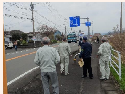
黒生野バス停付近にて実施した工事車両の現地調査の様子
