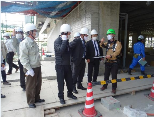
新庁舎建設現場で説明を受ける
