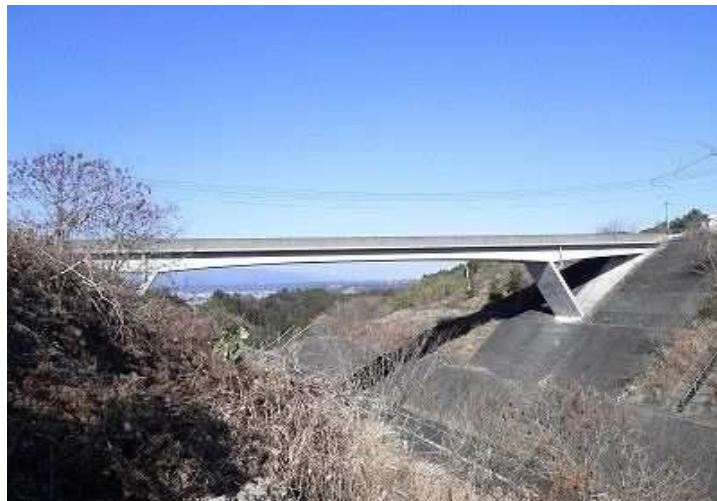
図 10 道路を跨ぐ橋梁の例（西都市管理 別府原橋）
