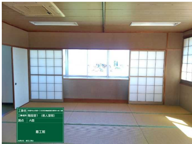
着工前 (2階和室)
