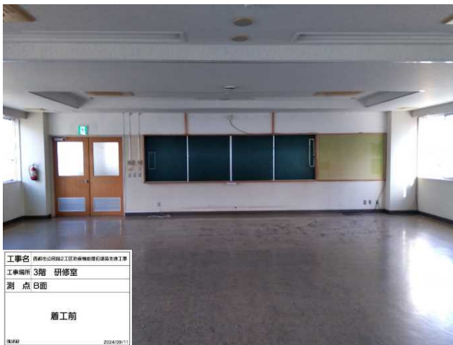
着工前 (3階研修室)
