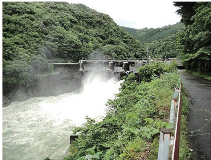
写真 3-2-15 放流を行う杉安ダム
