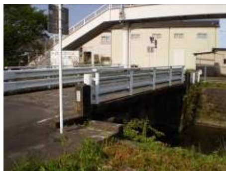
長寿命化修繕計画の平田橋
